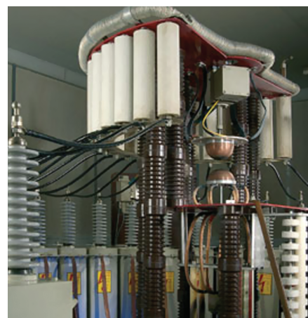
Рис. 1. Испытательная установка в лаборатории компании DEHN + SÖHNE
